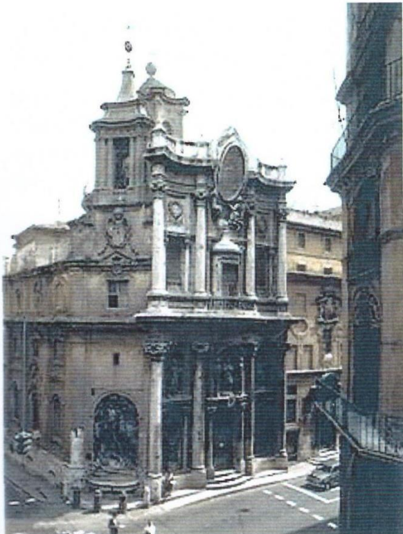
San Carlino alle Quattro Fontane in Rome, ontworpen door Borromini en gebouwd tussen 1634 – 1647.
